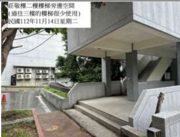
莊敬樓二樓樓梯通往三樓的樓梯空間
